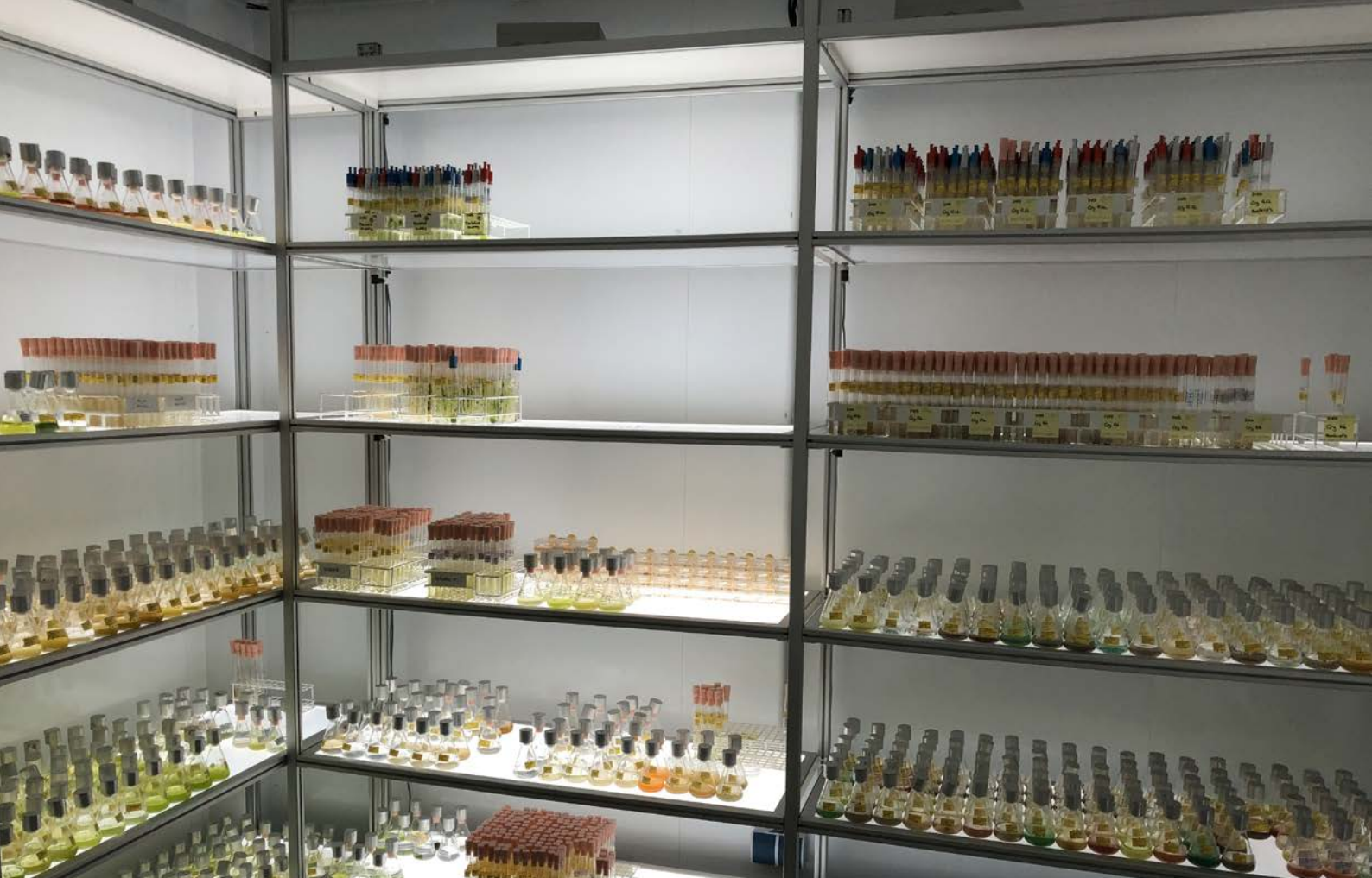
Abb.: Fest montierte Leuchtstofflampen an der Regalrückwand wurden durch modernste und flexible LED-Technik ersetzt.
