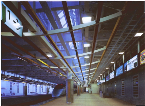
5 Im Auftrag der ostjapanischen Eisenbahngesellschaft erfolgte mit der Erschließung des Erholungsgebietes Yamagata auch die Umgestaltung des Shinjo-Bahnhofs. Dort sorgen 200 Endura für eine optimale Orientierung der Besucher und für eine wirtschaftliche Beleuchtungslösung.
